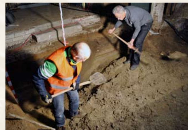
De deel: een zijvlak maken, het straatje langs de staanders, grupstenen en de gravers.
