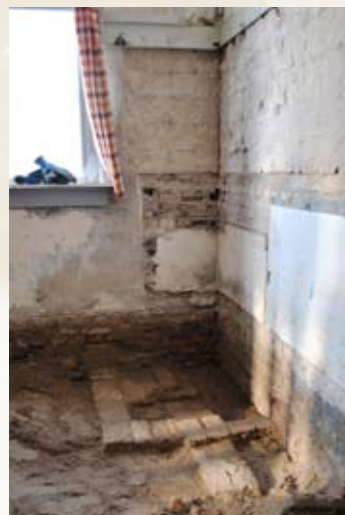
Geheel links: de plankhouders voor de kaasrijping, daarnaast de uitgegraven pompbak in de keuken.
